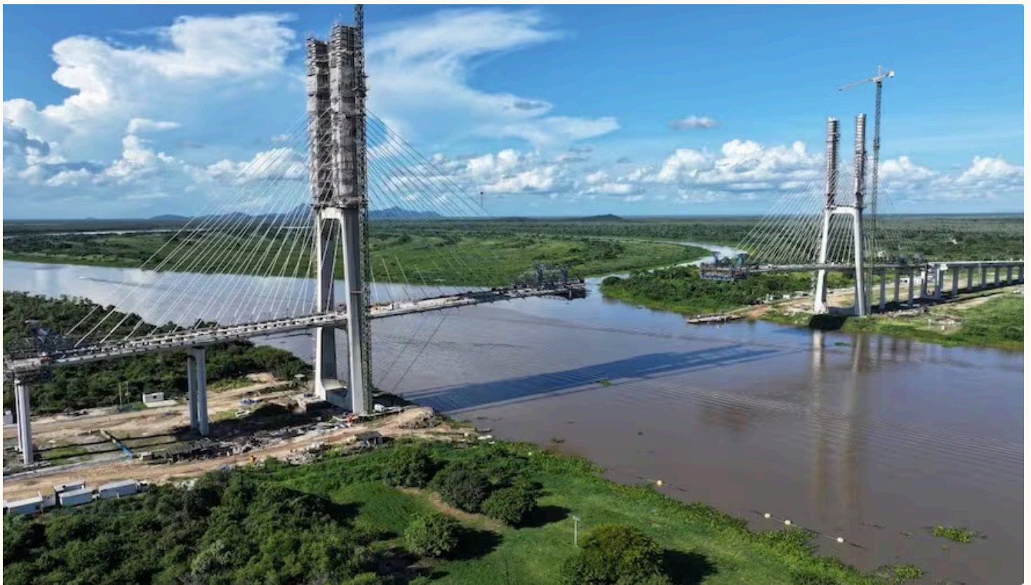
Puente de la Bioceánica con un 83% de la obra finalizada
